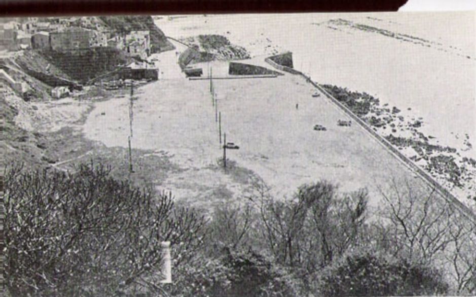
Muro construido por el Ayuntamiento, que cerró la pequeña ensenada, detrás del puerto de Algorta, en cuyo relleno se construirán instalaciones hoteleras y deportivas.
